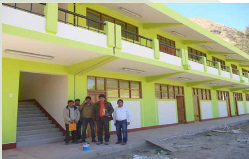
MEJORAMIENTO DE INFRAESTRUCTURA EDUCATIVA DE LA INSTITUCION EDUCATIVA MIXTO LOS LIBERTADORES
