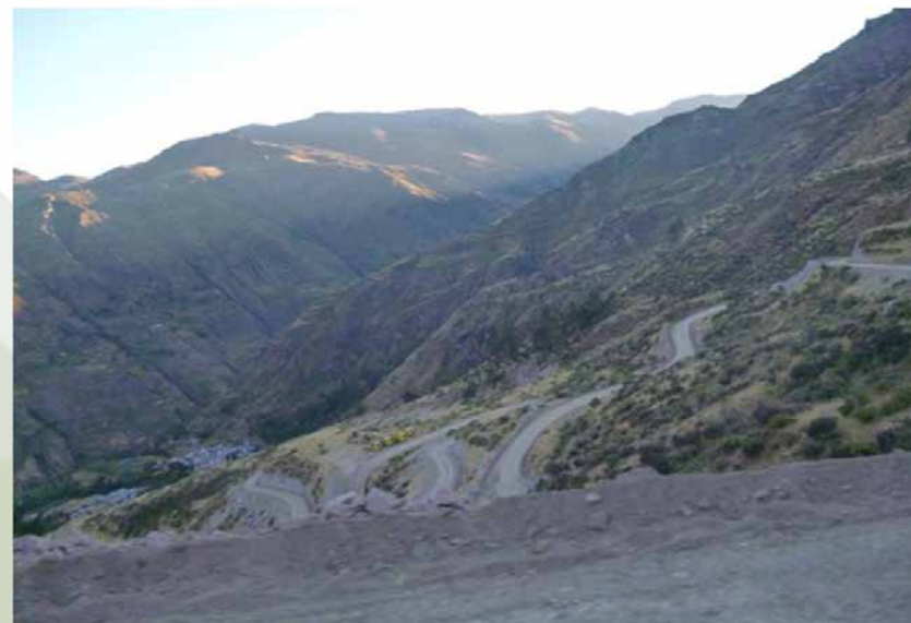
CONSTRUCCIÓN Y MEJORAMIENTO DE LA CARRETERA TANTARÁ CASACANCHA
