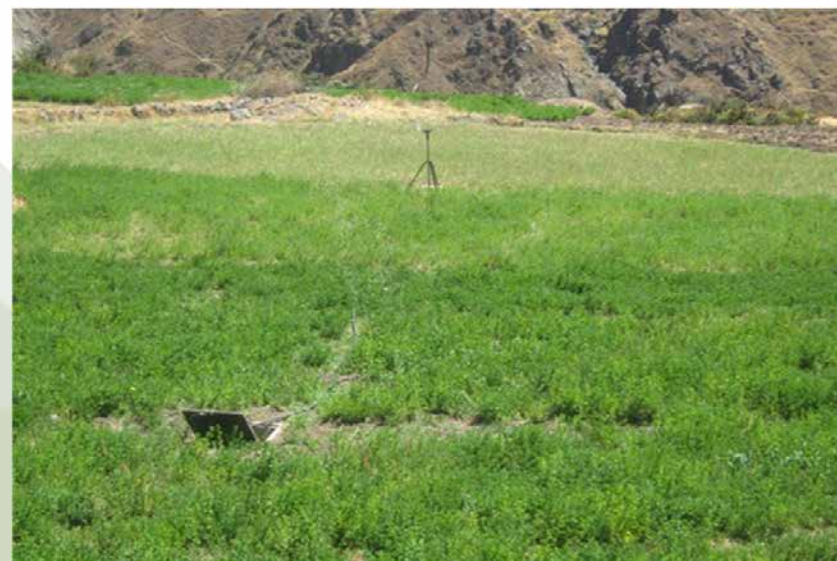
CONSTRUCCIÓN E INSTALACIÓN DEL SISTEMA DE RIEGO AURAHUA
