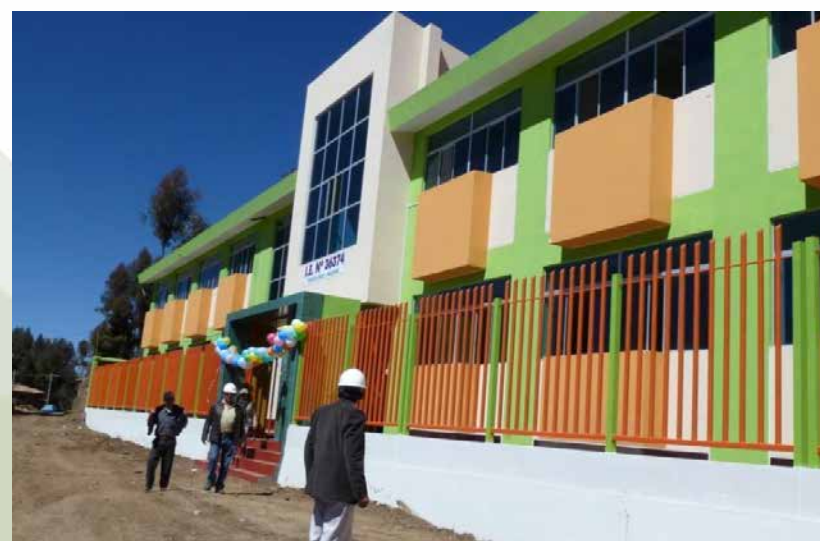
CONSTRUCCIÓN Y EQUIPAMIENTO DE LA INFRAESTRUCTURA DE LA I.E. 36374 DE CHECCO CRUZ- PAUCARÁ- ACOBAMBA
