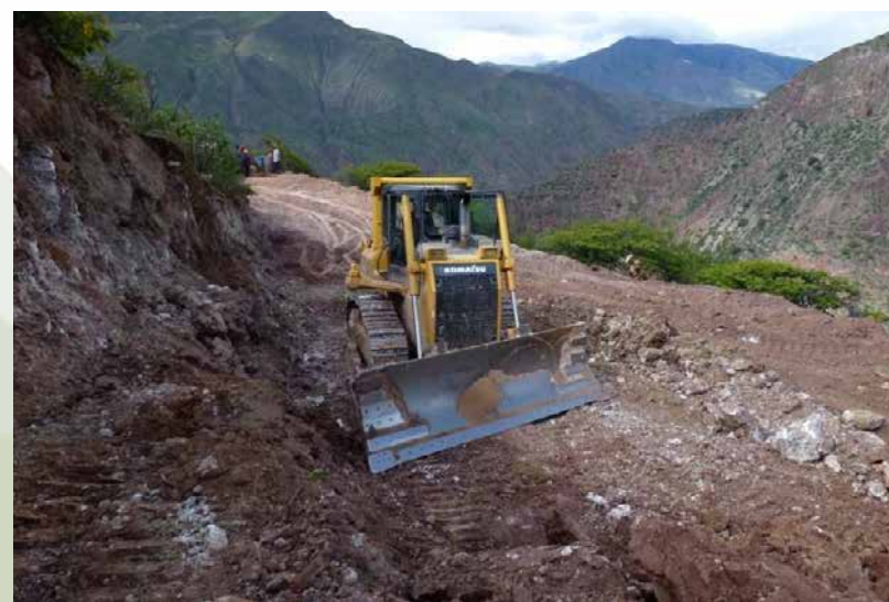
CONSTRUCCIÓN DE TROCHA CARROZABLE RURUNMARCA LLAHUECC – RIÓ MANTARO
