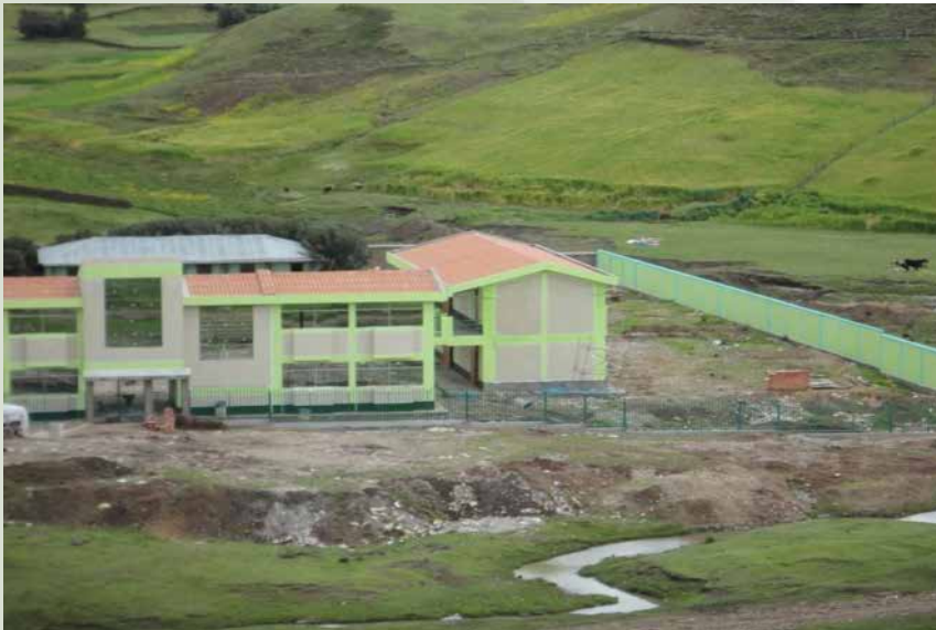
MEJORAMIENTO Y EQUIPAMIENTO DE LA INFRAESTRUCTURA DE LA INSTITUCION EDUCATIVA PRIMARIO N° 36334 DE PARCO ALTO- ANCHONGA - ANGARAES
