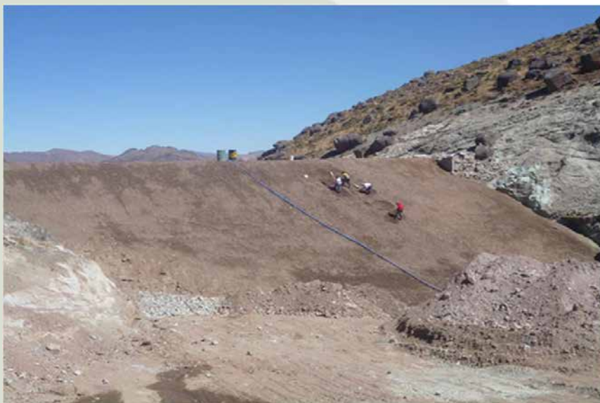
CONSTRUCCION DEL VASO DE REPRESAMIENTO DE HUARAJO
