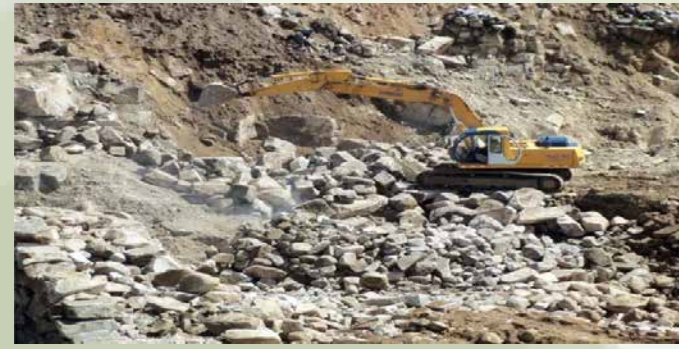
CONSTRUCCIÓN CANAL DE RIEGO ILLAHUASI-HUIRPACANCHA
