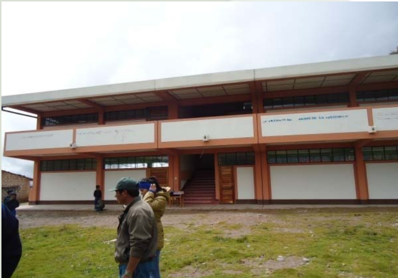
CONSTRUCCION Y EQUIPAMIENTO DE LA I.E.NRO 36286 CUTICSA-PROV.ANGARAES
