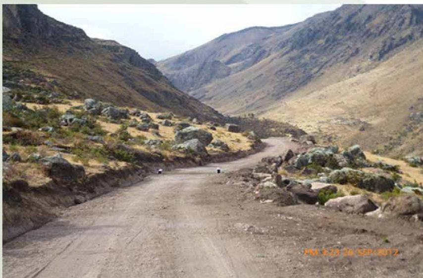
CONSTRUCCIÓN DE LA CARRETERA PUENTE MAYUCANCHA - PAMPA JUNIÍN - SANTO DOMINGO
