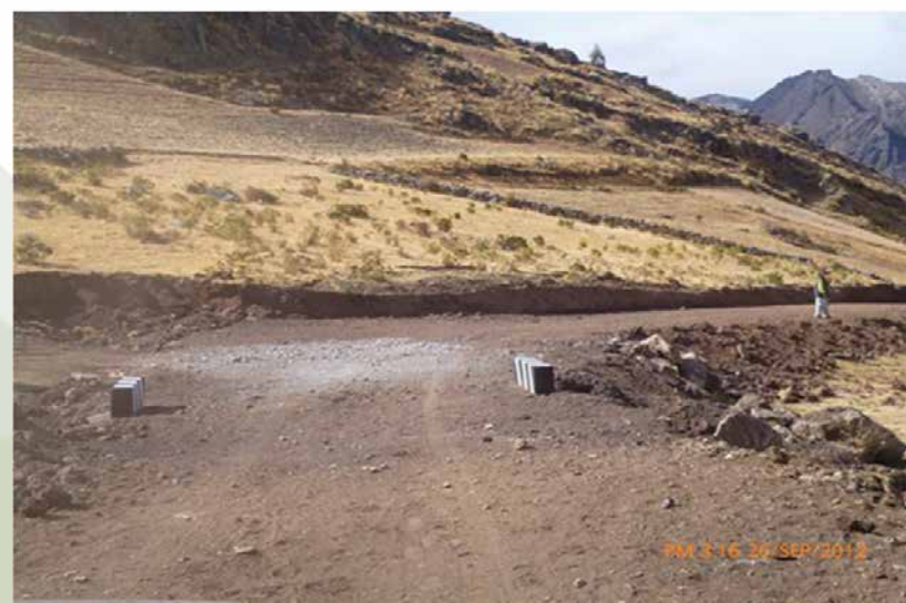
CONSTRUCCIÓN DE LA CARRETERA HUAYACCA - ANTACANCHA - COCHAMARCA
