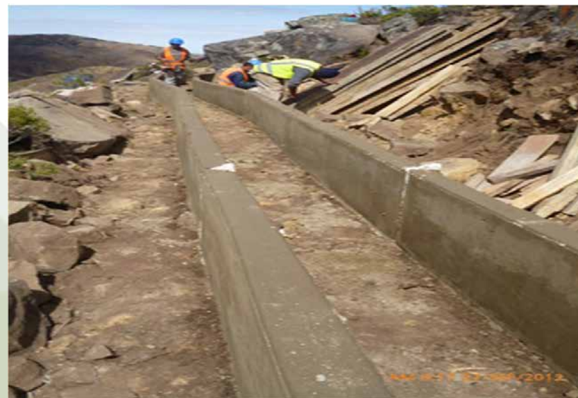
MEJORAMIENTO DE LA IRRIGACIÓN RUNTUPAMPA- PAMPACANCHA- CAJAMARCA
